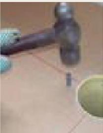
**5.** Con la ayuda de un martillo, introduzca los chazos plásticos en los orificios realizados; limpie el tubo y el cuerpo del ACOPLER y prepárese a soldar.
