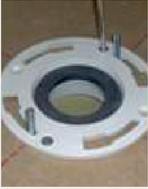
**7.** Ponga los tornillos para sujetar el sanitario en las correderas, verifique que queden en los ejes. Ahora ajuste completamente los tornillos de piso. Ubique el sello de PVC blando en la cavidad base del ACOPLA.
