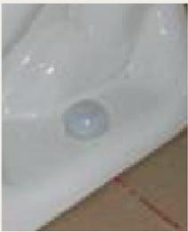
**9.** Una vez instalado el sanitario con el ACOPLA, instale manualmente el tapón roscado en el tornillo sobrante en la base de la taza, ajústelo firmemente.
