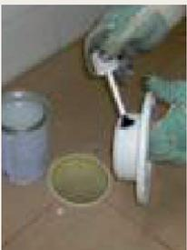
**6.** Suelde el ACOPLER al tubo de desagüe asegurándose que los ejes que aparecen en el ACOPLER, coincidan con los marcados sobre el piso.
