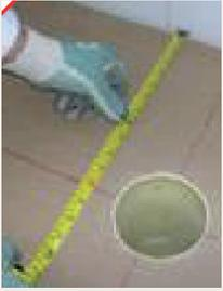
**1.** Comience instalación verificando la medida entre la pared y el centro del tubo ubicado en el piso, tenga en cuenta el tipo de sanitario que va a montar. Instale la brida provisionalmente y confirme si el sanitario cabe en el lugar.
