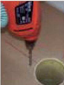
**4.** Con un taladro roto percusor y de acuerdo con la marcación efectuada, perforo los orificios con broca de concreto de 3/8".
