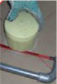
**2.** Corte el tubo del 4" del desagüe a ras del piso. Si el desagüe fue construido en 3" corte el ACOPLER según la marca que se encuentre sobre el zosco y haga una pequeña regata en el piso alrededor del tubo.
