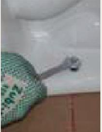
**8.** Monte la taza sobre los tornillos de fijación, ajuste las tuercas del tornillo alternadamente hasta que la taza quede fija y no se mueva. Ahora emboquille la base con un mortero o con silicona con fungicida.
